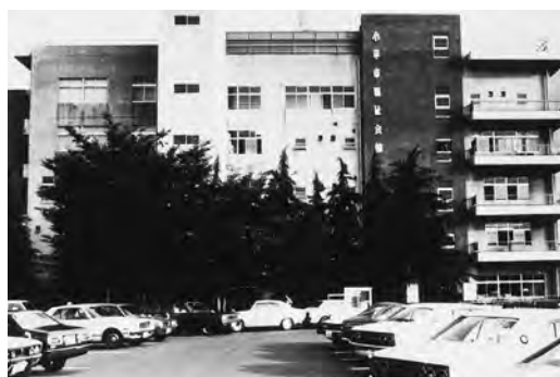
福祉会館開館（昭和 47 年）
