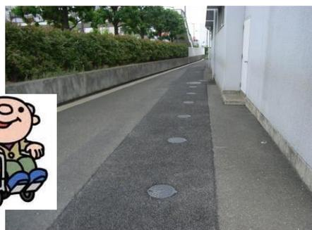
マンホールトイレシステム設置工事が完了した様子。普段はマンホールの蓋だけ見える状態。車いすの方も使用できるように通路を確保。
